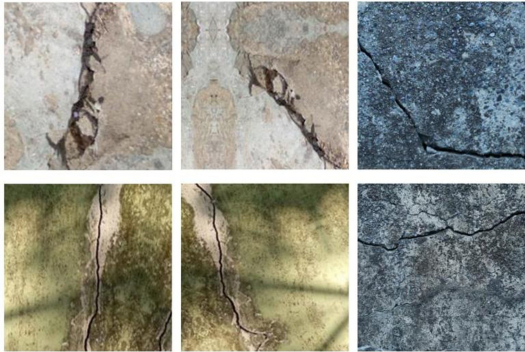
图5 大坝裂缝数据集样例
