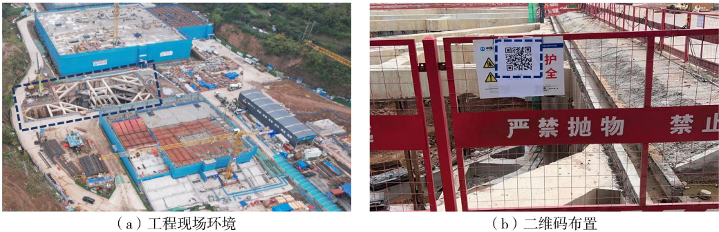
图 4 深基坑施工现场
