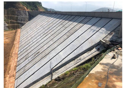
(a) 混凝土防渗面板
