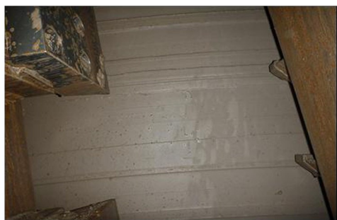
图9 开挖面处的泥膜
