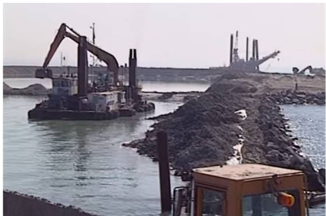
图10 Peberholm 人工岛围堰施工现场 Fig.10 Peberholm artificial island
