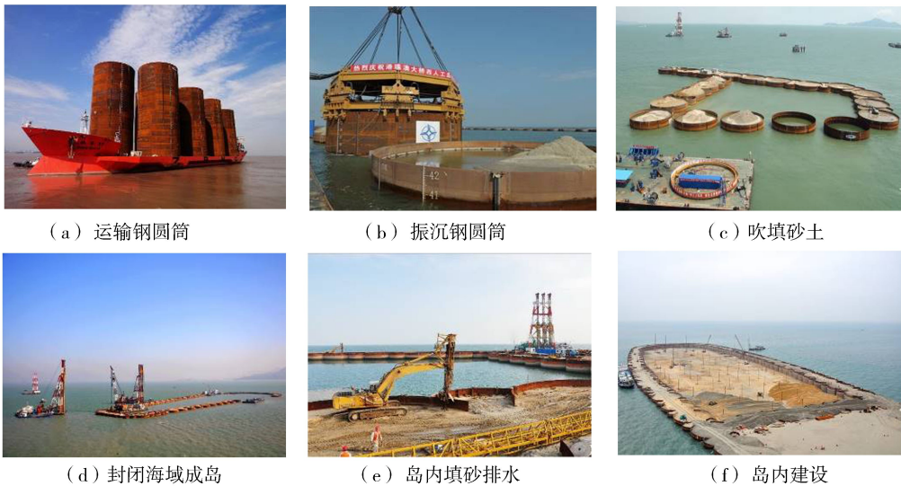
图 13 港珠澳大桥快速成岛施工技术
