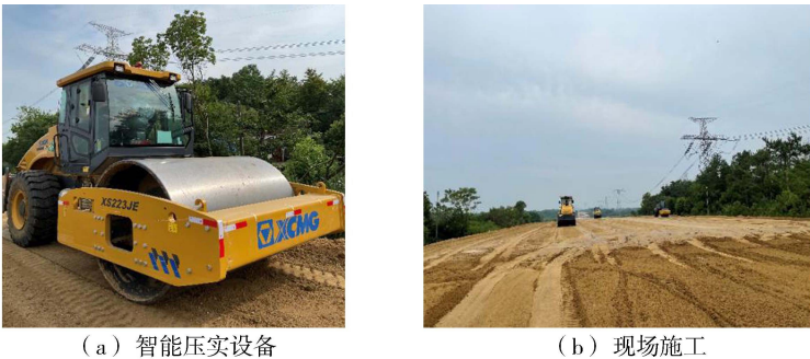
图 4 智能压实试验施工现场
