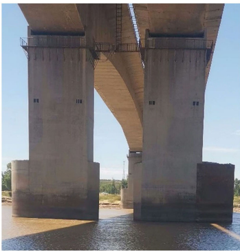
图 2 黄河特大桥组合桥墩
