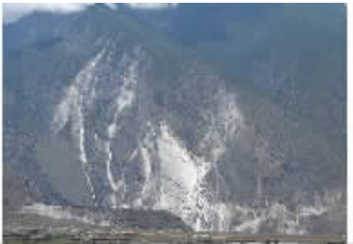
图 1 滑石板高边坡地形 Fig. 1 Topography of Huashiban slope
