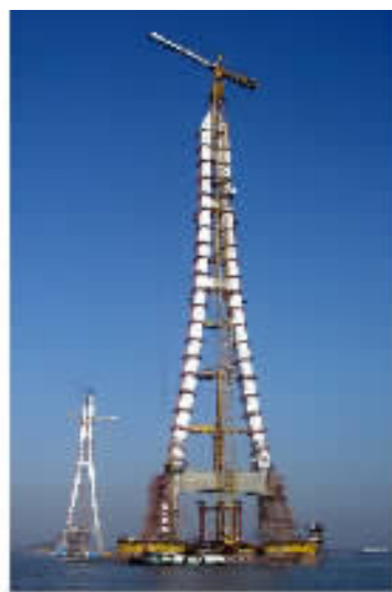
图 1 钢索塔现场施工
