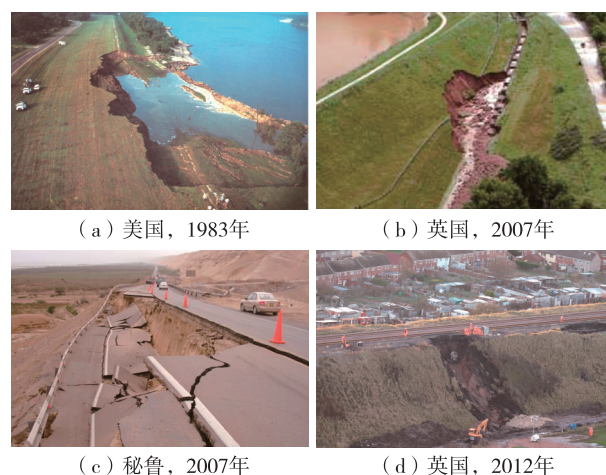
图 1 实际边坡破坏形态(引自 Google 图片网)
