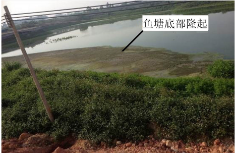
图3 K4+800 ~ K4+900 段地表无隆起,邻近鱼塘底部隆起
