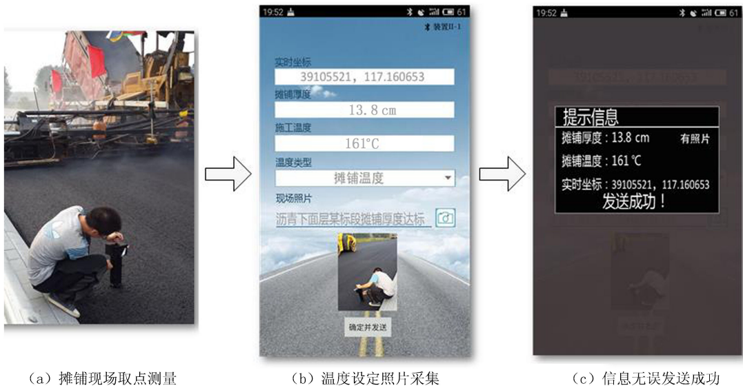
图 4 便携式测温测厚仪施工现场应用图
