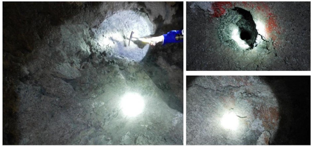
图 1 地下厂房岩体蚀变现象
