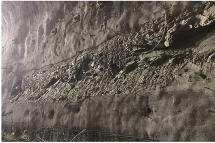
图 8 岩体蚀变洞段的岩壁开挖成型情况
