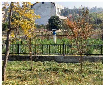
(a) 集中式微动力污水处理站
