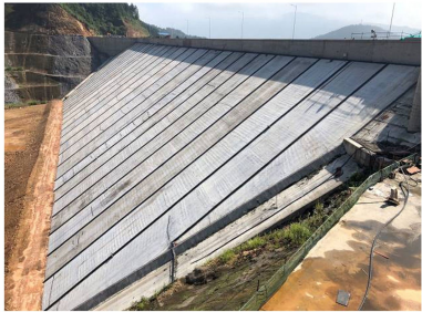
(a) 混凝土防渗面板
