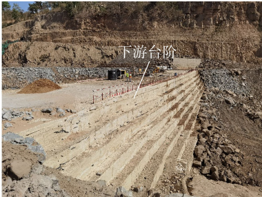
图5 围堰下游侧台阶面预制挡块模板施工
