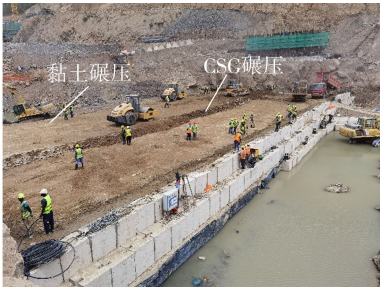
图7 围堰主体 CSG 变态碾压施工
