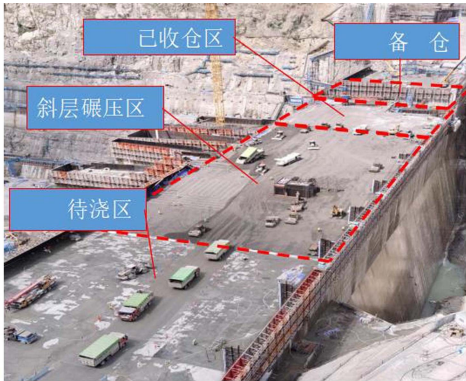
图 7 大斜层碾压通仓连续滚动施工技术
