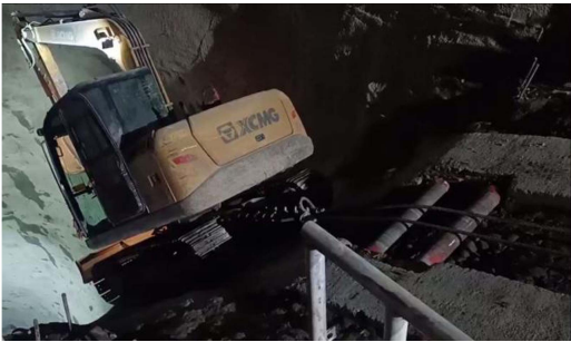
图2 无人挖机下斜井施工
