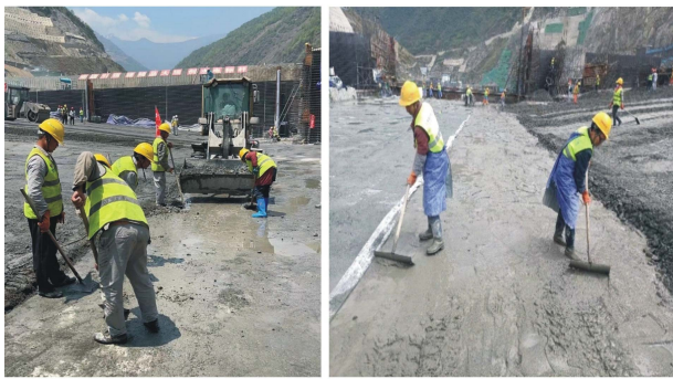
图3 斜层碾压端头处理
