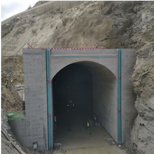
图2 埋件安装完成
