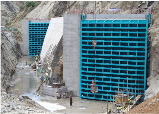
图3 叠梁门安装完成
