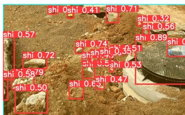
图 11 回填土石块目标检测实现效果
