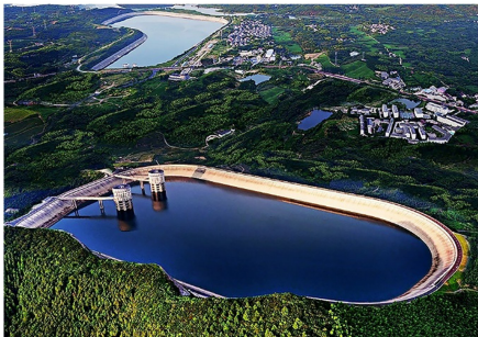
图 2 电站上下水库全景
