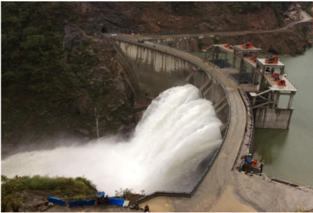
图 2 佰佳水电站堆石混凝土拱坝
