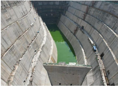
图 5 东庄水库二道坝
