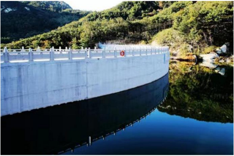
图 1 蒙山水库堆石混凝土拱坝
