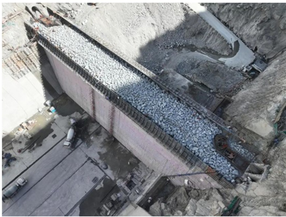
图 6 叶巴滩水电站堆石混凝土二道坝通仓浇筑
