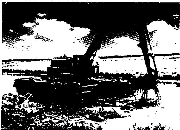
图1 SLWY-60型水陆两用挖掘机在三江平原沼泽地施工
