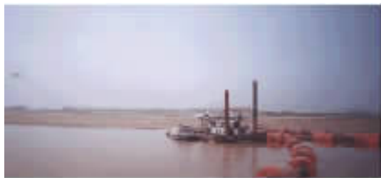
图1 施工中的 120 m³/h 绞吸式挖泥船
