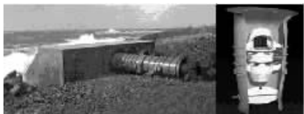
图4 英国 500 kW 岸式波浪能转换装置
