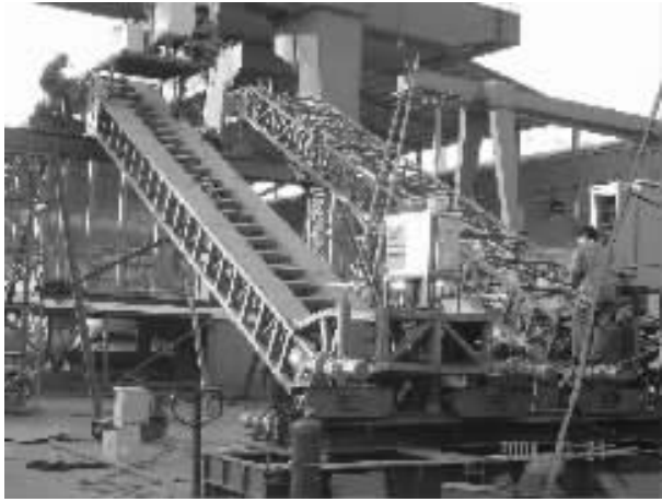
图 1 CCFM04 型和 SCFM04 型设备在车间安装调试
