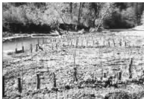
图3 柳树根和柳树种植护岸
