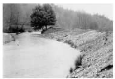
图2 爱尔兰 Creek 河段柳树插枝法护岸
