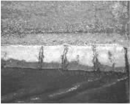
图1 槽身露筋
