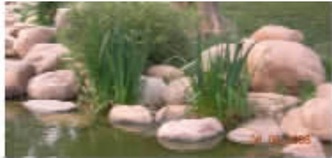
图5 小涑河生态固岸河道
