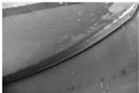
图 6 葛洲坝水电站导叶喷涂前后叶片裙边磨蚀状况
