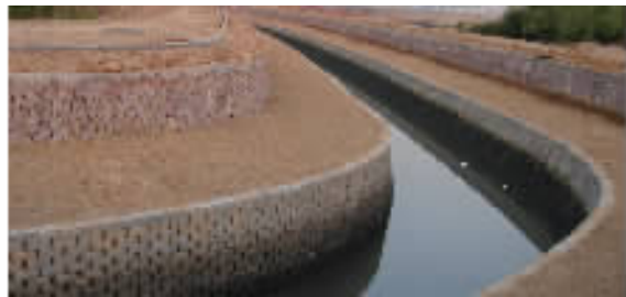
图3 丽水海潮河尾段荣勋挡墙(砌筑完工时)
