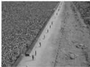
图6 土工膜与坝基防渗墙锚固
