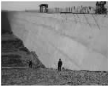
图1 土石坝与混凝土导墙连接部位
