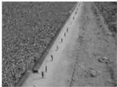
图6 土工膜与坝基防渗墙锚固
