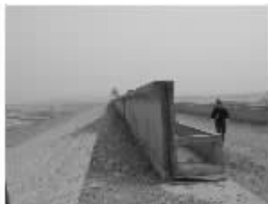
图5 土工膜与坝顶防浪墙锚固
