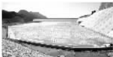
图 4 土工膜防渗施工完成后的上水库
