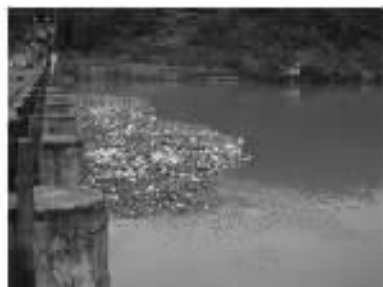
图4 沙溪口水电站进水口前漂浮物堆积
