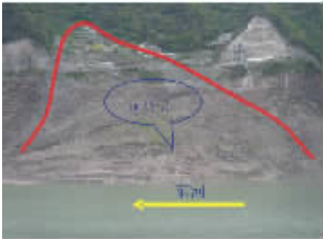
图 1 主沟 1 号崩坡积堆积体
