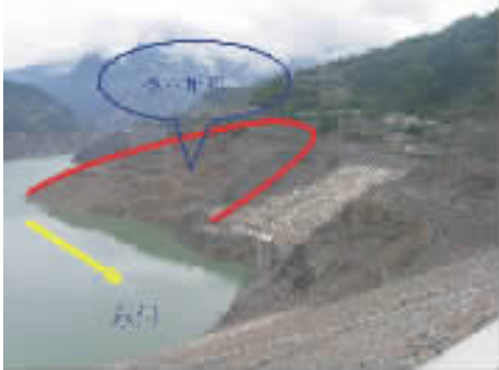
图 2 近坝左岸冰水堆积体
