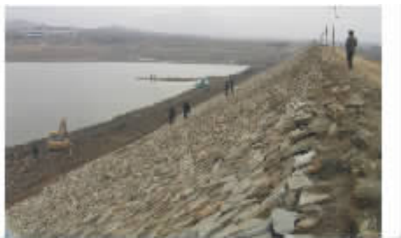
图 1 加固前的安家林水库
