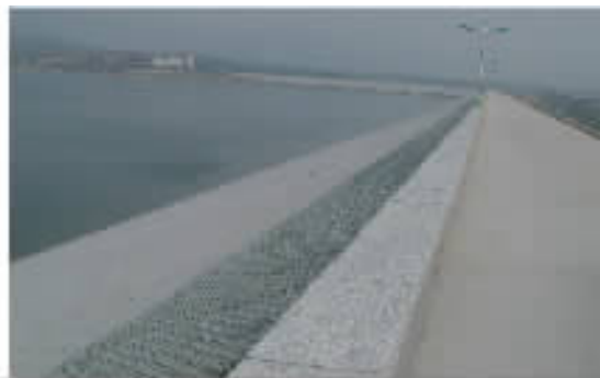
图2 加固后的安家林水库
