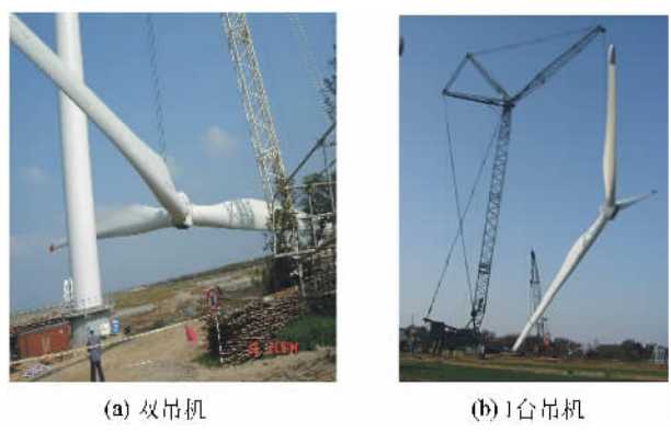
图2 轮毂和叶片吊装
