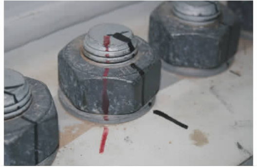
图 2 力矩线的正确画法
