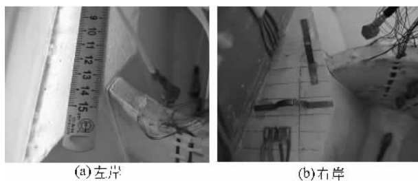
图8 坝肩破坏状态
