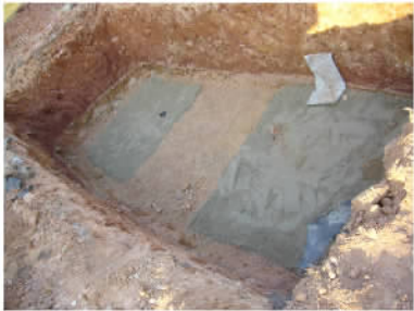
图 4 平板静载试验前现场情况
