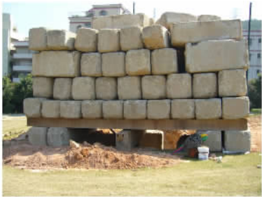
图 5 平板静载试验进行中现场情况
