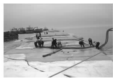
图3 袋装砂围堰施工现场
