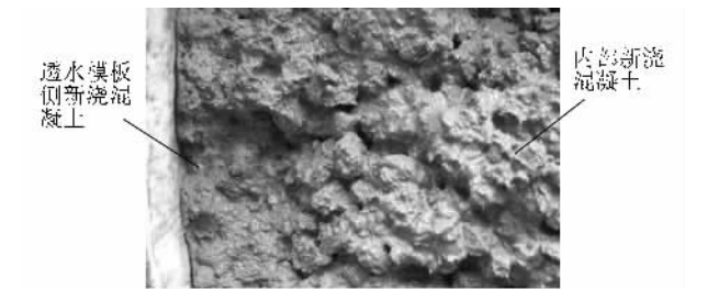
图 2 透水模板浇筑混凝土拌合物状态
