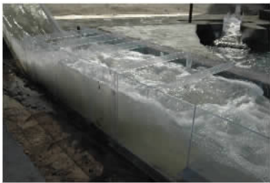
图 2 溢洪道消力池池长 110 m、边墙加高时水流流态
