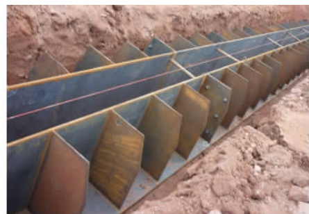
图 2 钢结构导梁
