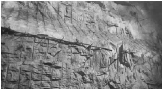
图 4 岩石条件较好部位岩台开挖效果
