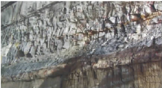
图 5 岩石破碎部位岩台开挖效果
