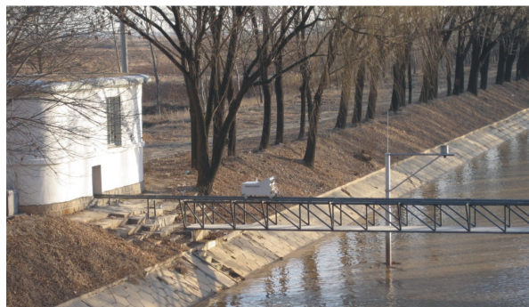
图1 测流系统轨道及小车运行
