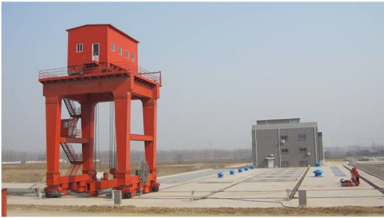
图 5 韩庄泵站双向可转向门式启闭机与副厂房
